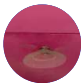
Muro separador Wall separator
